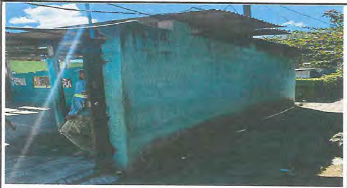
Foto 3: INSTALACION DE CANAL COLONIAL
