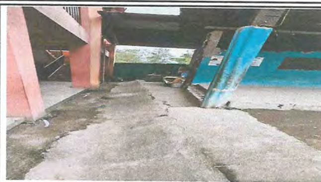
Foto 2: NIVELACION DE GRADA EN COCINA Y FUNDICION DE LOSA
