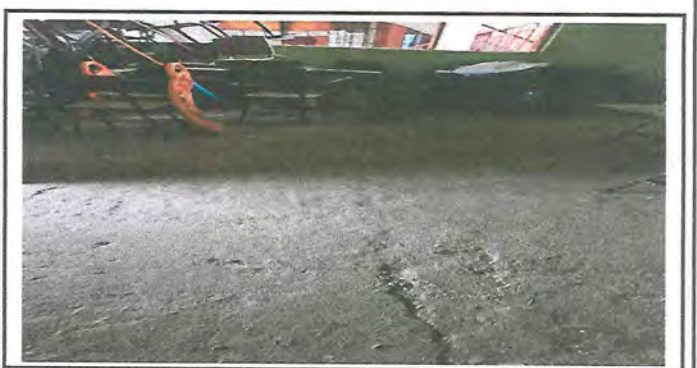
Foto 6: INSTALACION DE PISO DE GRANITO
