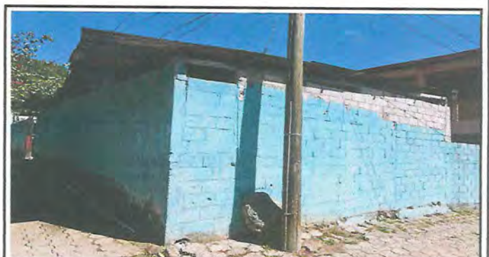
Foto 4: INSTALACION DE CANAL COLONIAL
