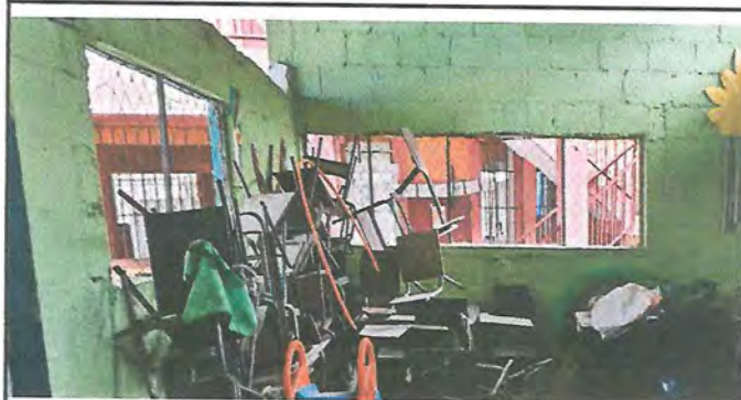
Foto 4: SUSTITUCION DE BALCONES
