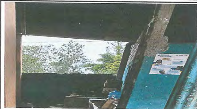
Foto 1: NIVELACION DE PAREDES EN MURO PERIMETRAL
