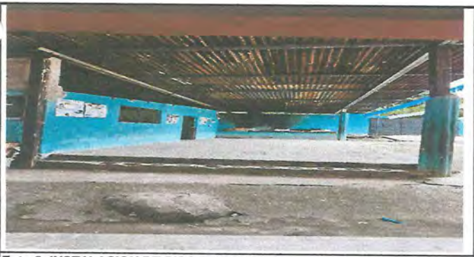
Foto 5: INSTALACION DE PISO DE GRANITO
