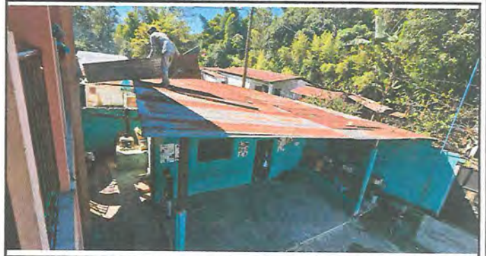
Foto 2: SUSTITUCION DE LAMINA Y ESTRUCTURA METALICA EN AULA, CORREDOR Y COCINA
