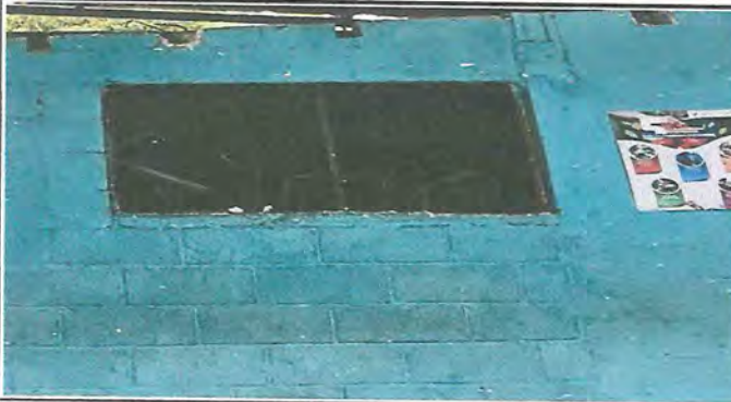
Foto 3: SUSTITUCION DE BALCONES
