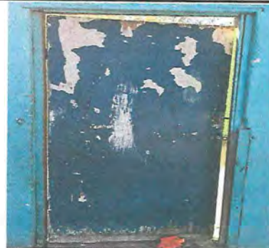
Foto 2: SUSTITUCION DE PUERTA DE AULA
