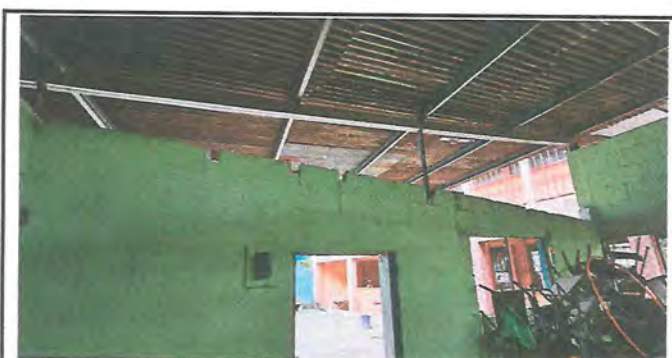
Foto 6: NIVELACION DE PAREDES EN AULA
