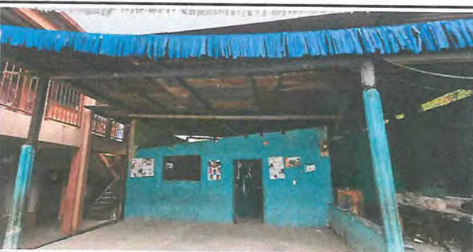
Foto 5: NIVELACION DE PAREDES EN AULA
