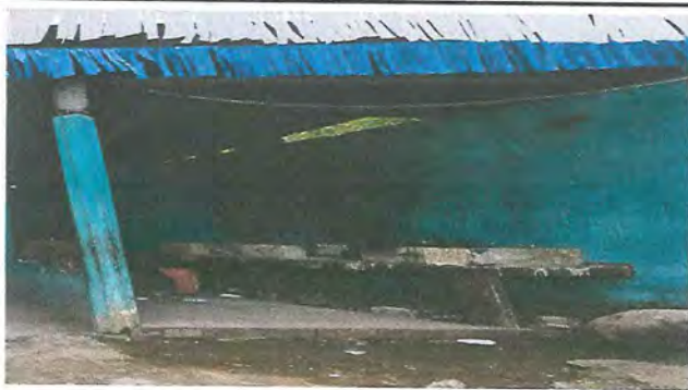
Foto 3: FUNDICION DE LOSA EN COCINA
