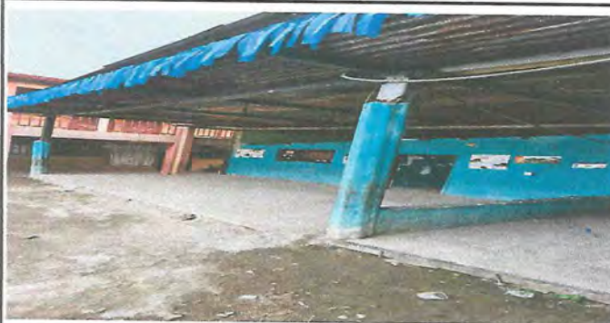
Foto 1: INSTALACION DE PISO DE GRANITO
