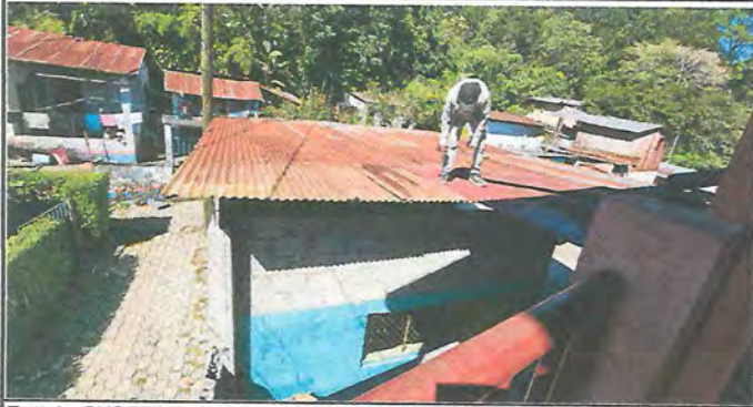
Foto1: SUSTITUCION DE LAMINA Y ESTRUCTURA METALICA EN AULA, CORREDOR Y COCINA
